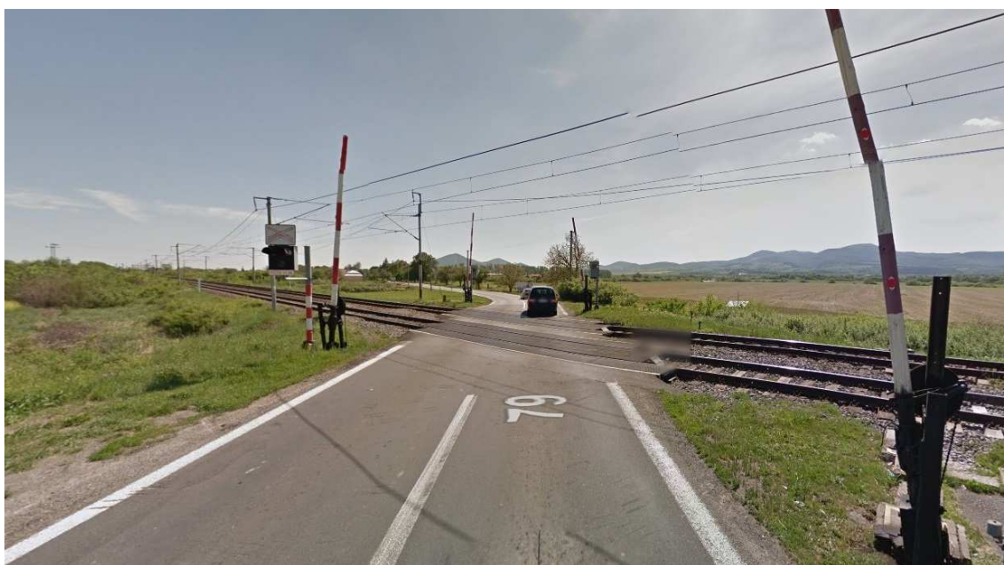
Obr. 15 - Železničné priecestie pred Čerhovom
